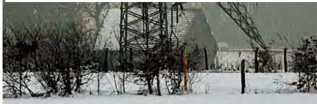
Abgeknickter Strommast
